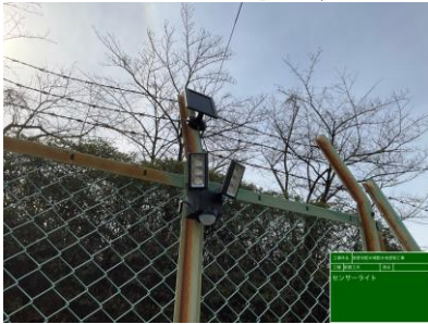
センサーライト設置状況
