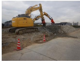
破碎 仕分け (コンクリート塊と鉄筋分別)
