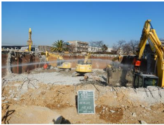
解体作業状況
