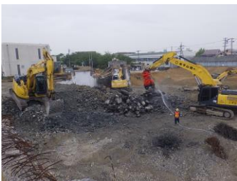
解体作業状況
