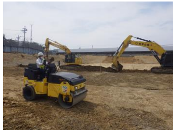
既設No.2、3配水池 土工 埋戻し作業状況
