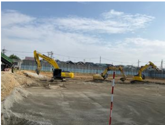
埋戻し状況写真
