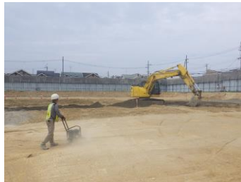
埋戻し状況写真
