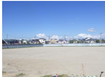
既設No.2、3配水池 土工 埋戻し完了
