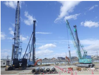
新設No.2配水池 基礎杭 施工状況
