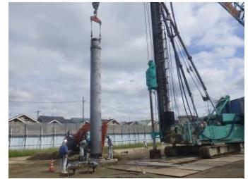
新設No.2配水池 基礎杭 施工状況
