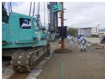
新設No.2配水池 基礎杭 施工状況
