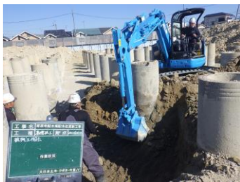
新設No.2配水池 基礎杭残土撤去状況
