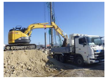
新設No.2配水池 杭残土運搬（汚泥搬出）状況
