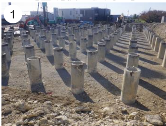
【基礎杭打設完了】
