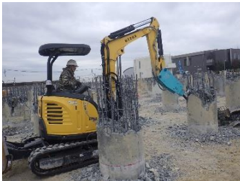
新設No.2配水池 杭頭処理状況
