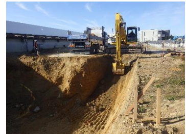
新設次亜塩素棟 掘削状況
