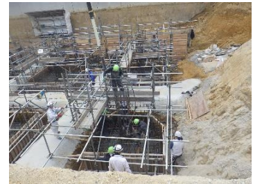
新設次亜塩素棟 コンクリート打設状況
