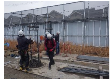
新設No.2配水池 鉄筋組立状況
