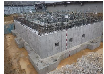
新設次亜塩素棟 鉄筋組立状況
