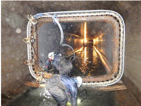
【管更生工事による管きよの耐震化（左：施工中、右：施工後）】
