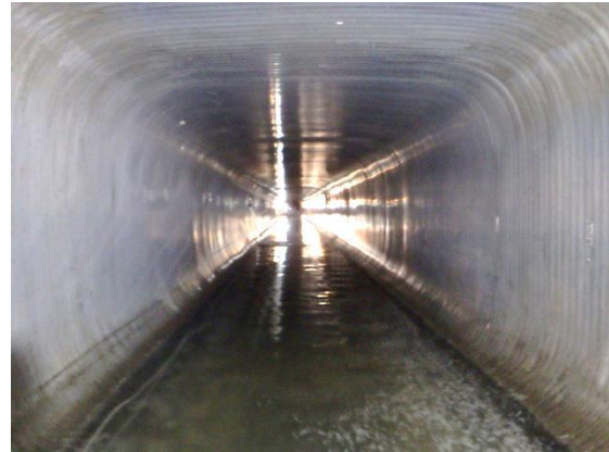
【管更生工事による管きよの耐震化（左：施工中、右：施工後）】
