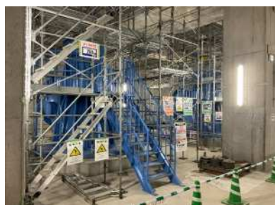
雨水ポンプ据付完了
