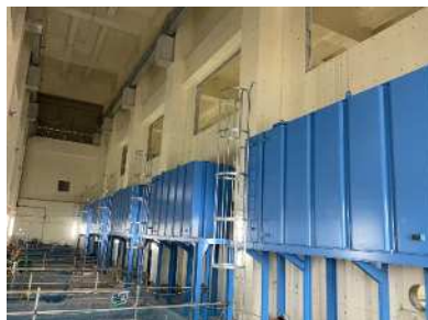
減圧水槽据付完了
