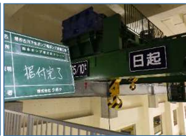
天井クレーン据付完了
