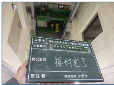
天井クレーン据付完了
