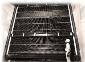
【除塵機】 水の中のゴミを取る機械です
