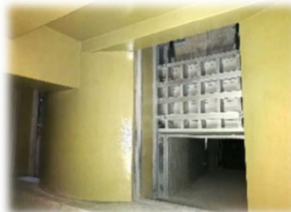
【集砂装置】 水の中の砂を取る機械です
