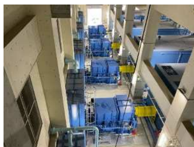
雨水ポンプ用減速機据付完了
