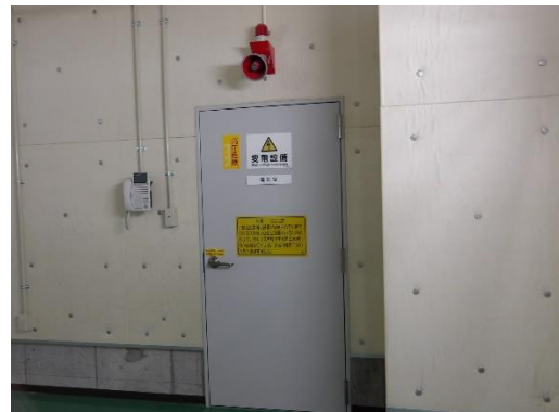
＜自家発電機室（事故発生側）から見た扉写真＞
