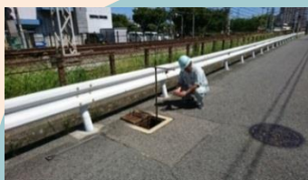
管路の水圧調査
