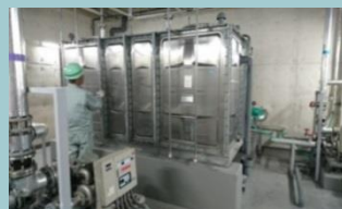
貯水槽の調査
