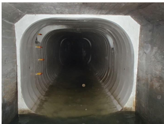
管更生工事による管きよの耐震化
