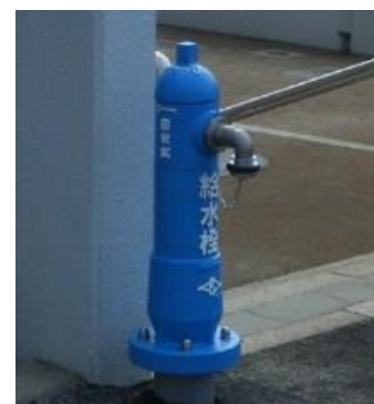
災害時給水栓写真(出典:仙台市)
