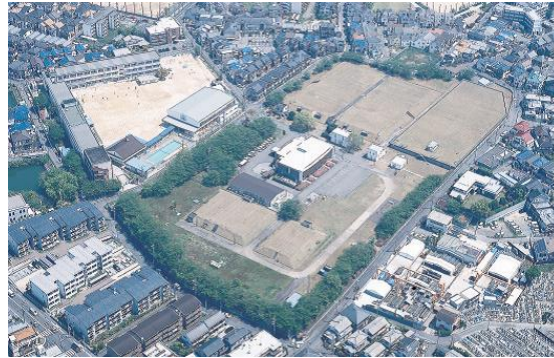
家原寺配水場 (応急給水の本部)
