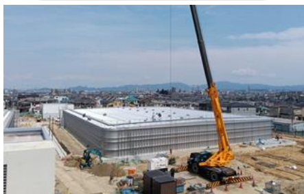
更新工事の状況
