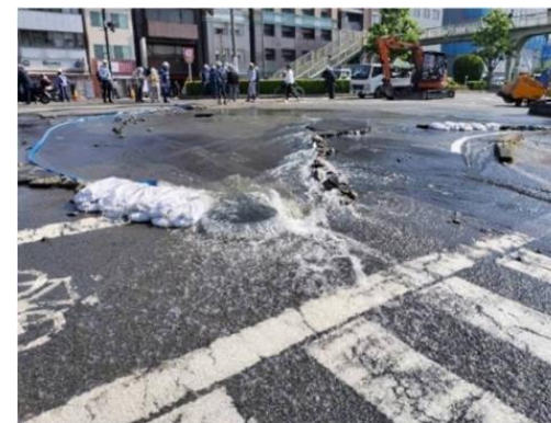
鋳鉄管漏水（京都市）
