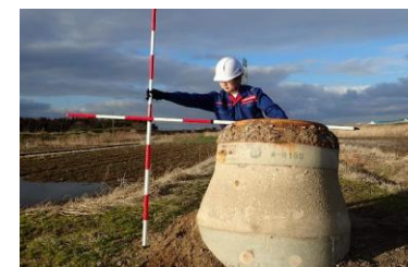
マンホール浮上現場（中能登町）
