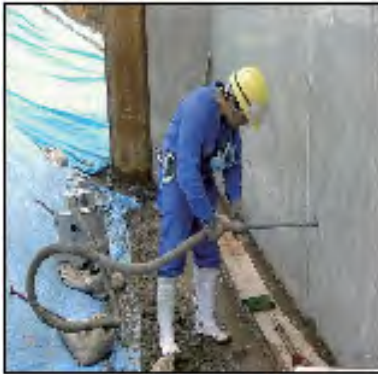
耐震補強工事
