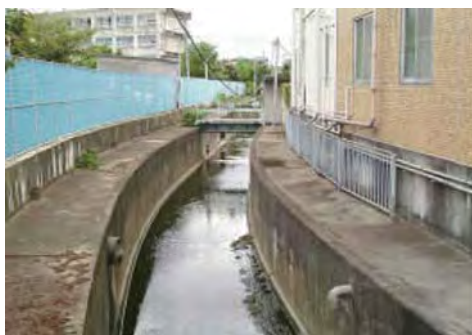
都市内水路の例
