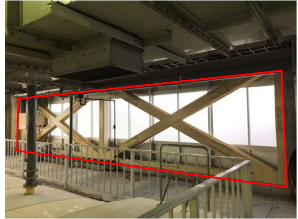
「ブレース※の設置」による耐震化
