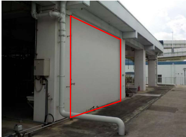
「耐震壁の設置」による耐震化
