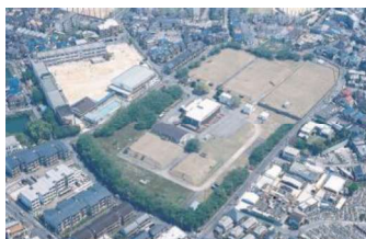
家原寺配水場 (応急給水の本部)
