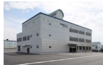
災害対策センター (下水道管路調査支援都市の集積基地)
