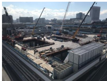
（令和 4 年 2 月の工事写真）
