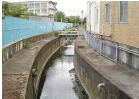
都市内水路の例
