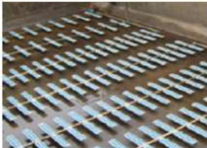
(例) 低圧損型メンブレン散気装置
