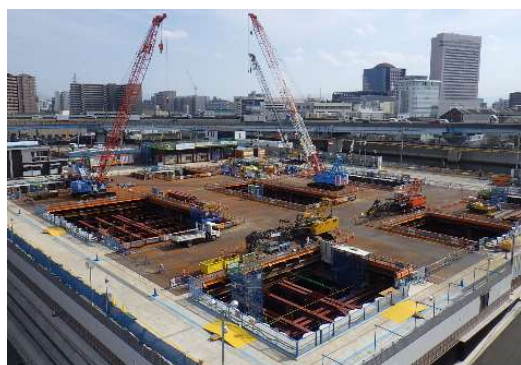
古川下水ポンプ場施工状況
