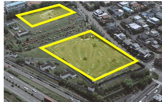
詳細な診断が必要な配水池（晴美台配水場ほか）
