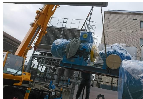
ポンプ設備の更新工事
