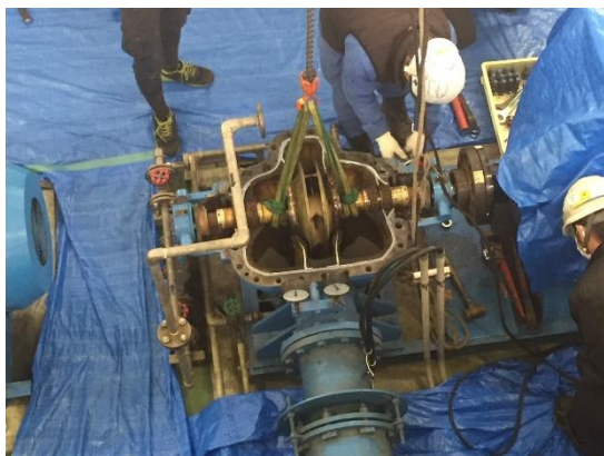
ポンプ設備の分解点検
