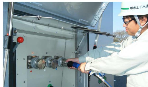
移動電源車からの給電作業
