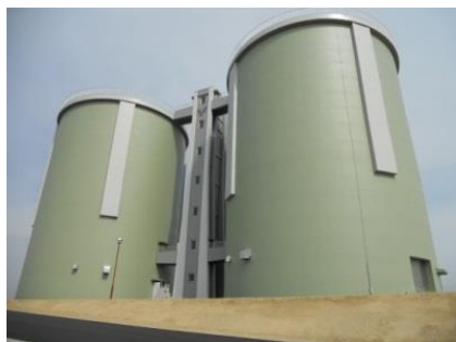
浅香山配水場 高架配水池
