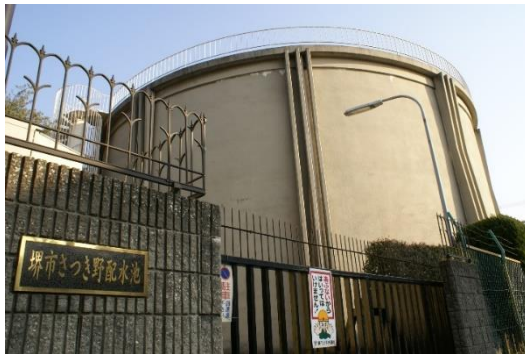
2池化されていない耐震性の低い配水池（さつき野配水池ほか）
