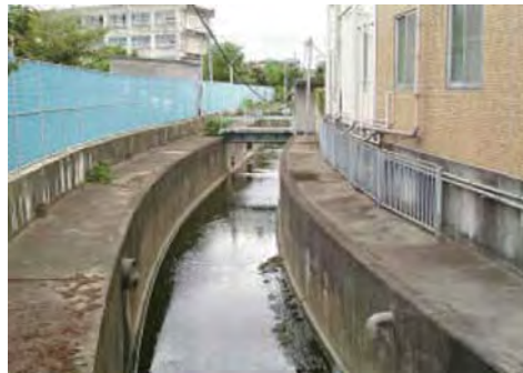
都市内水路の例
