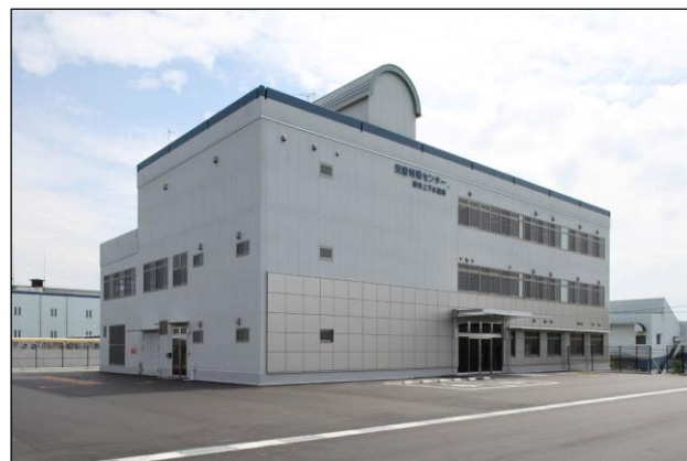
災害対策センター
