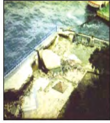
処理場施設被災による水域の汚染
