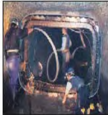
管路更生工事
