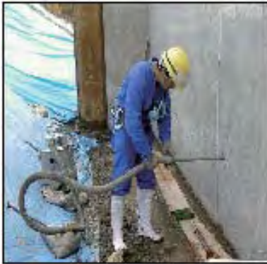
耐震補強工事
