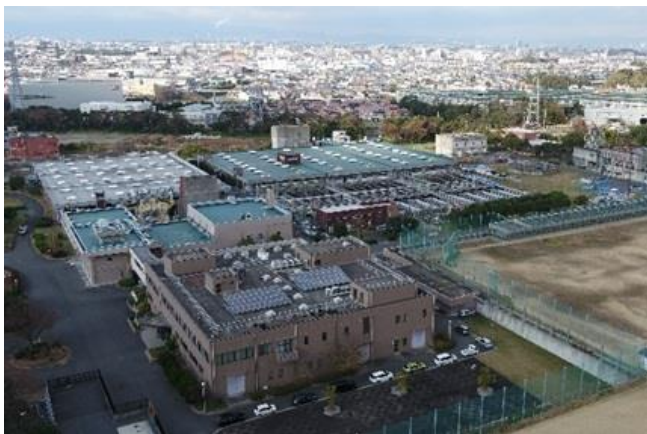
泉北水再生センター 昭和44年供用開始
