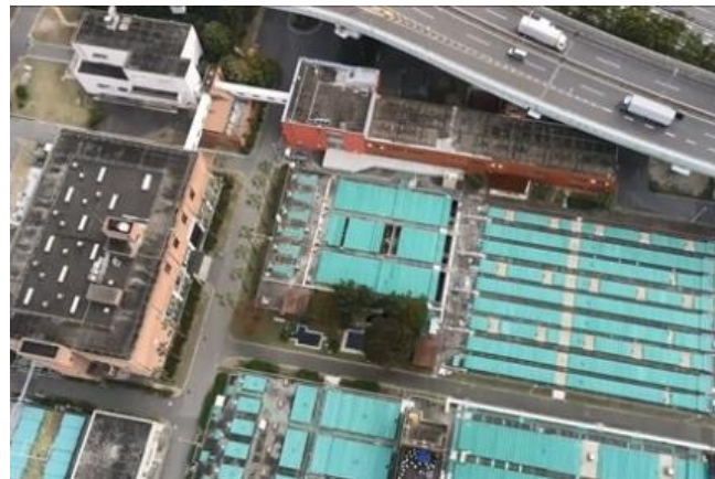
石津水再生センター 昭和47年供用開始
