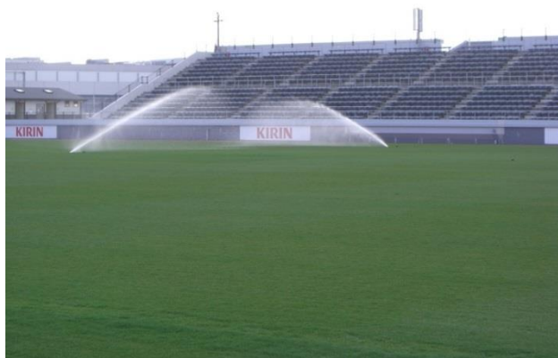
再生水の散水状況（J-GREEN 堺）
