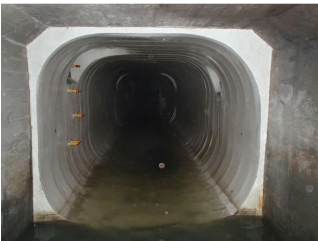
管更生工事による管きよの耐震化
