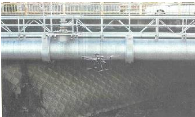
（水管橋を点検するドローン）
