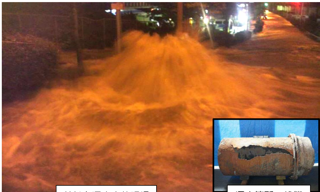
若松台漏水事故現場
