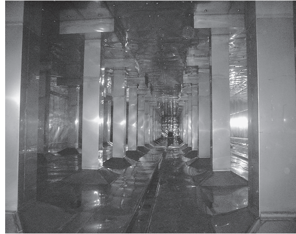
平成17年3月に完成した岩室配水場のステンレス張りの配水池内部
