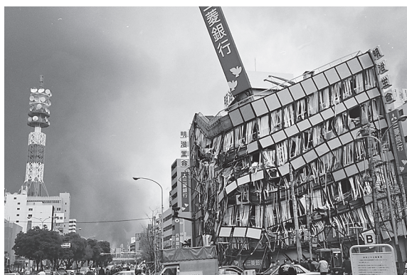
震災発生直後の神戸市兵庫区水木通1丁目の様子 (写真提供：神戸市)
