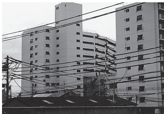
倒壊したマンション
