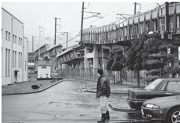
倒壊した山陽新幹線の高架橋
