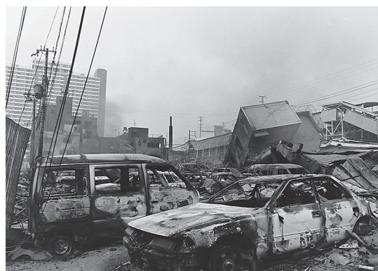
震災発生直後の神戸市長田区の様子 (写真提供：神戸市)
