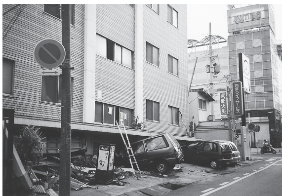
ビルの倒壊で押しつぶされた車
