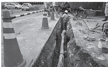
水道工事現場
