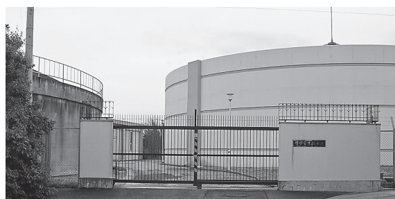
菅生配水池 (左側は低池、右側は高池)
