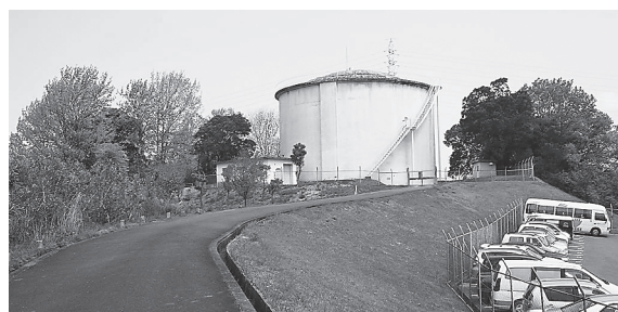
御池台配水池
