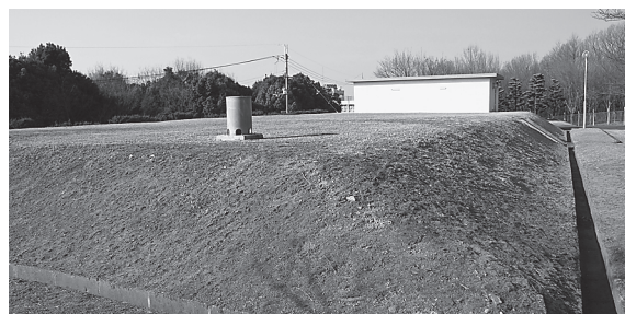
岩室高地配水池
