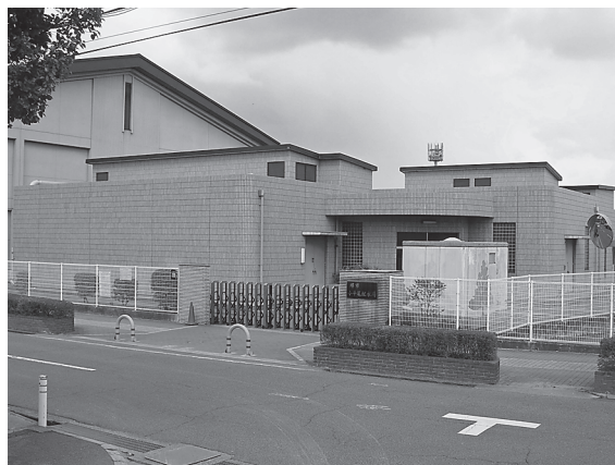
小平尾配水場
