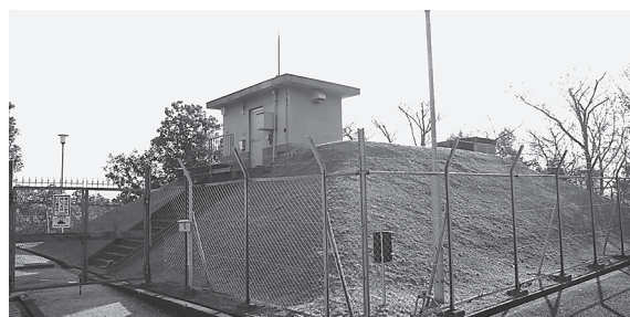
鴨谷台配水池
