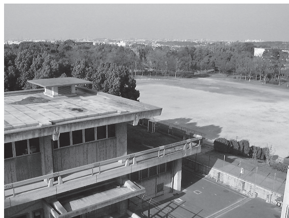
桃山台配水場
