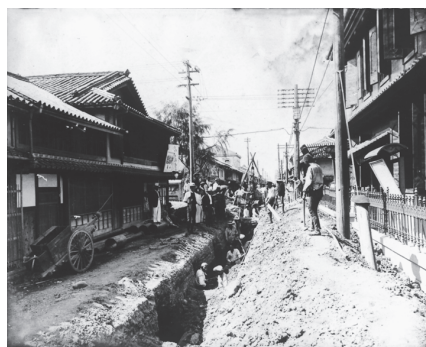
最初の水道布設工事（大道筋、明治42年頃撮影）
