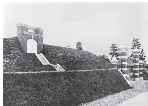
明治43年1月に完成した天王貯水池（大正元年頃撮影）
