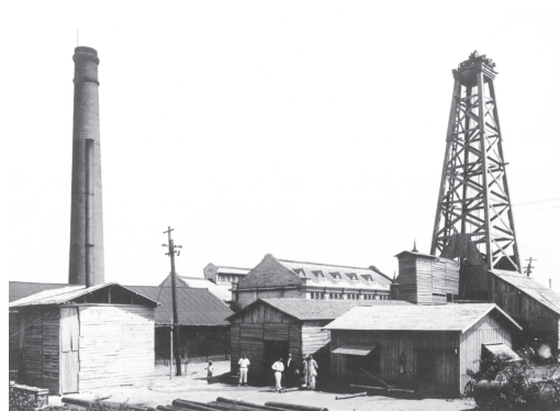
1号さく井工事場
