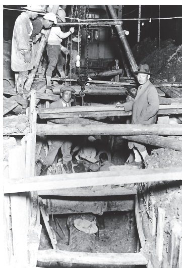
浅香山浄水場内の送水自記量水器室前で配水管布設工事（昭和2年）
