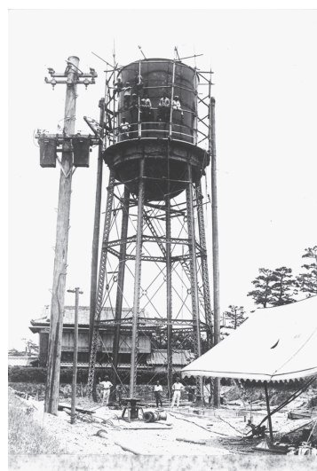
天王貯水池内に高地配水塔を建設（昭和2年）
