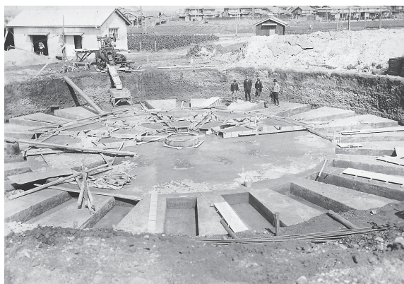
地上式調節池基礎工事（昭和11年4月）
