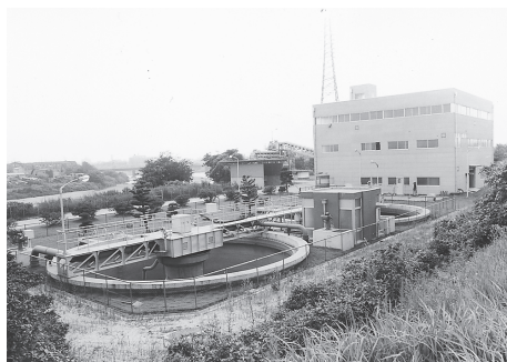
浅香山浄水場内に完成した汚泥処理設備（昭和49年12月）
