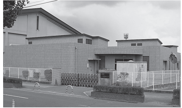
塩素注入施設が設置された小平尾配水場
