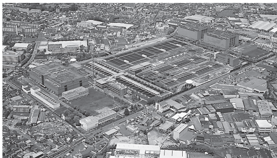
高度浄水処理施設が設置された村野浄水場
