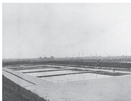
堺市水道創設当時（明治43年頃）の浅香山浄水場の緩速ろ過池
