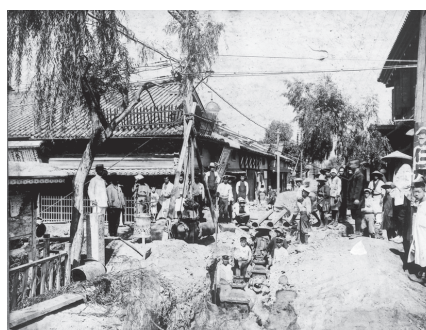
最初の水道布設工事（大小路を東から撮影 明治42年頃）
