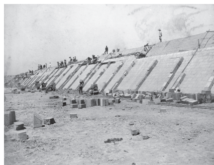
浅香山浄水場沈でん池築造工事（明治42年頃）
