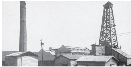
1号さく井工事現場（大正9年～）
