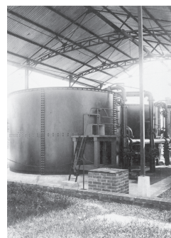
キャンデー急速ろ過器（大正10年11月設置）さく井で揚水した水のアンモニアをろ過するため、イギリスのキャンデー社から取り寄せたもの
