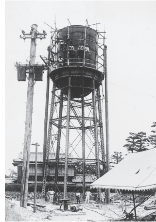
天王貯水池内に高地配水塔を建設（昭和3年）
