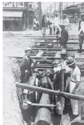
大阪市からの分水受水のための阿倍野橋交差点横断工事（大正13年）
