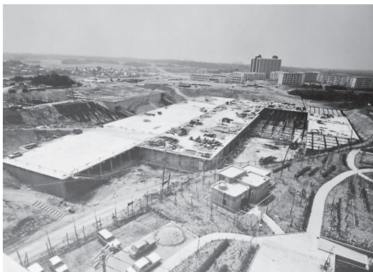
泉ヶ丘第3配水場（現・桃山台配水場）の築造工事（昭和48年5月撮影）
