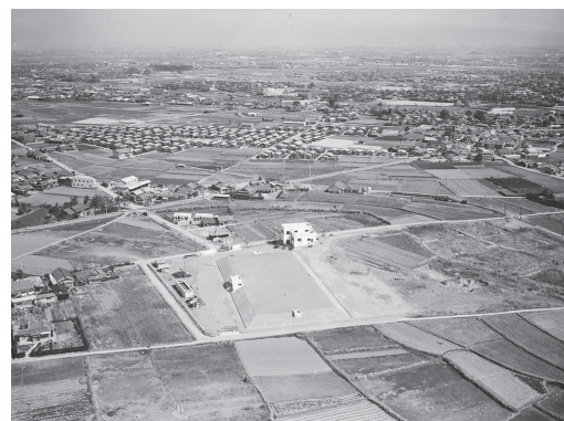
泉ヶ丘第1配水場（現・陶器配水場）昭和40年
