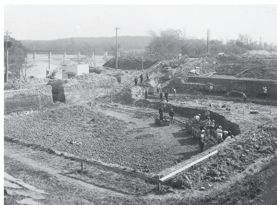
7・8号緩速ろ過池（昭和13年）
