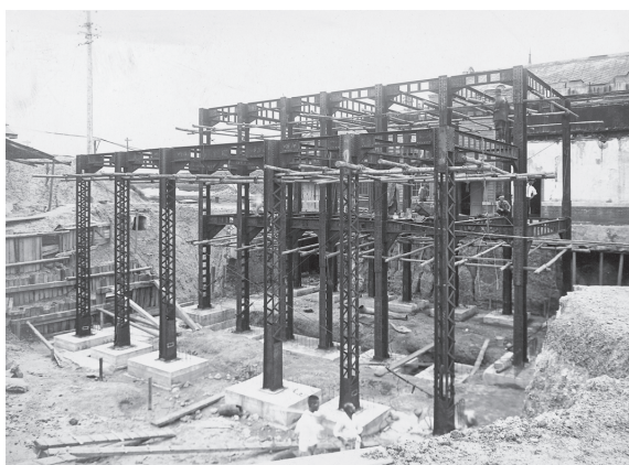
ポンプ室築造工事（昭和10年頃）
