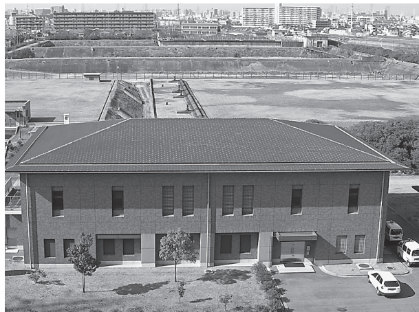
浅香山浄水場ポンプ棟（平成7年3月完成、平成18年3月撮影）
