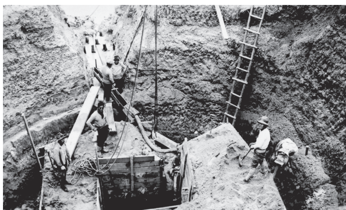
コンクリート製取水井の設置工事（昭和9年）
