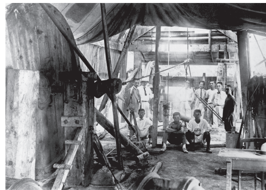
2号さく井工事現場の内部（昭和3年）
