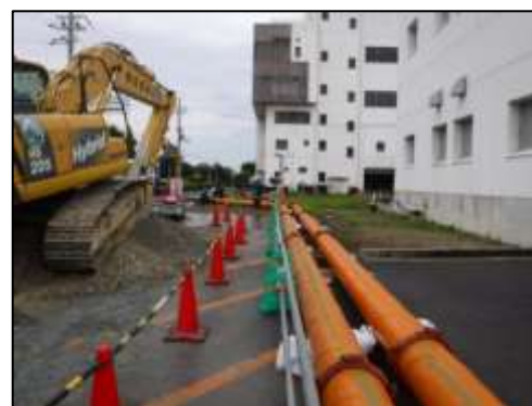
φ350mm 鋼管設置状況
