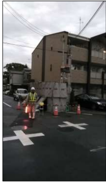
仮設配管設置完了・防音対策実施写真
