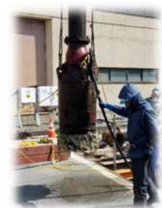
雨水仮設ポンプの清掃状況
