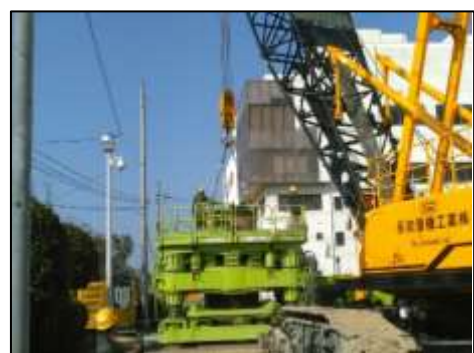
立坑部の鋼管圧入状況
