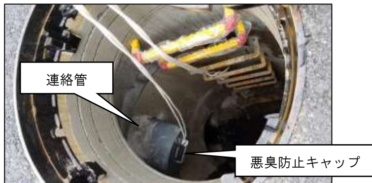
汚水管から雨水管への切り替え（マンホール内）
