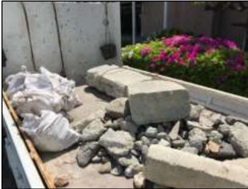
推進時に回収されたコンクリート殻
