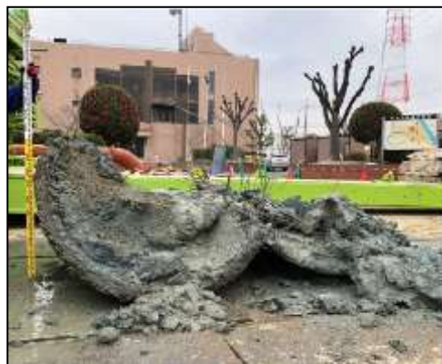
回収したポンプ井立坑部の下水道管
