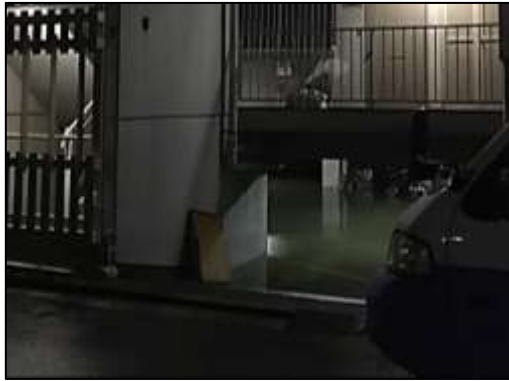
地下駐車場浸水状況
