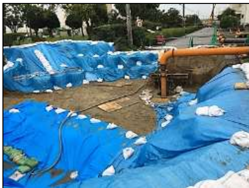
仮設配管、仮設ポンプの設置状況
