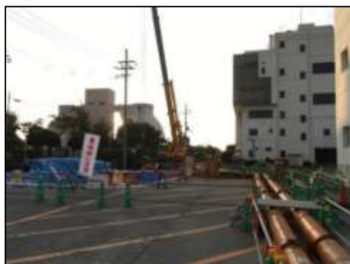
φ350mm 鋼管設置状況
