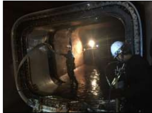
《参考》 他工事におけるライニング施工状況
