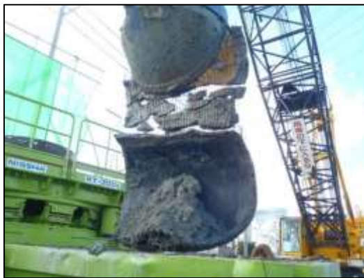
立坑築造時における下水道管の撤去状況写真
