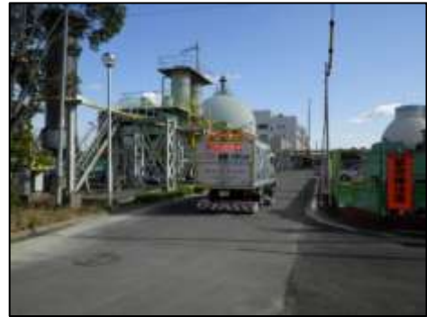
空洞調査の状況
