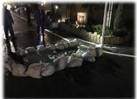
常磐町内での土のうによる仮設水路
