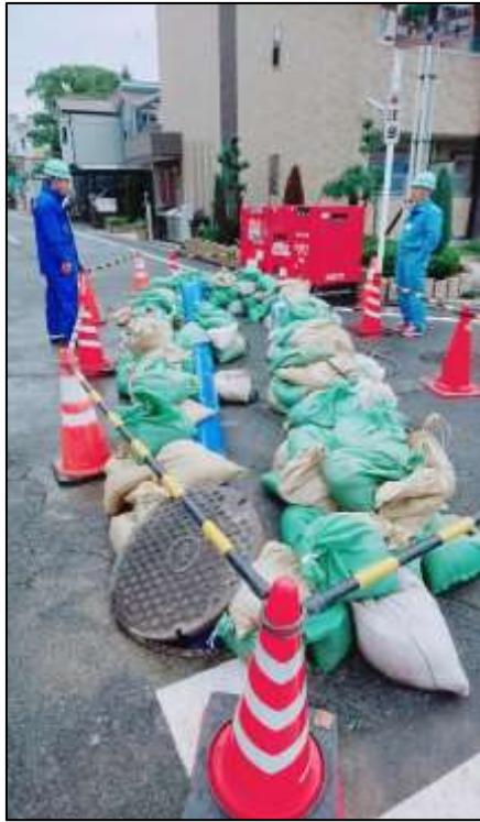
溢水対策として設置した土のう仮設水路
