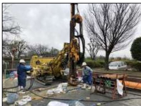
ボーリング調査状況
