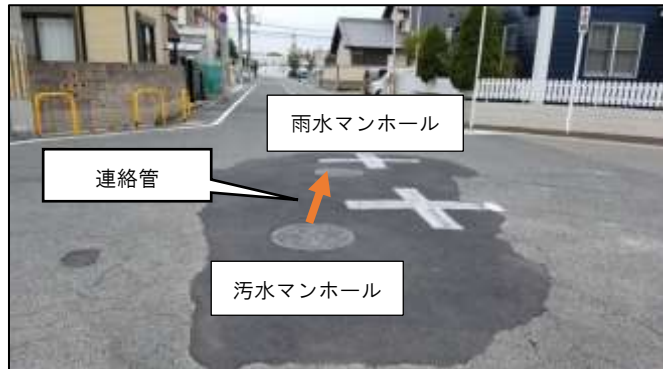
汚水管から雨水管への切り替え（道路状況）
