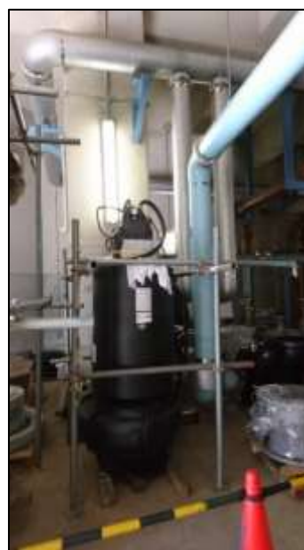
汚水ポンプ \phi 400\text{ mm}
