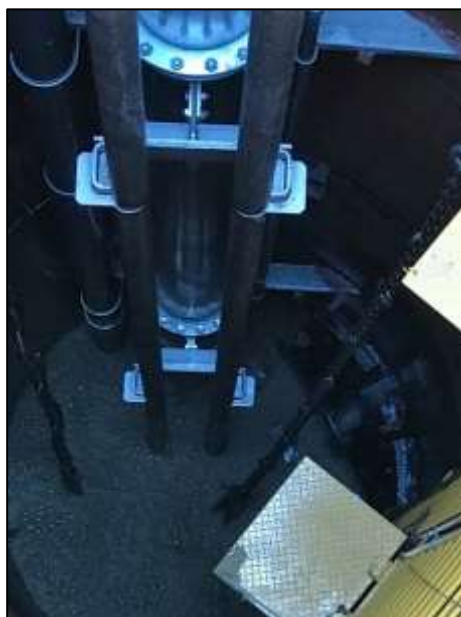
ポンプ井立坑内にポンプを設置している状況
