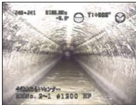
下水道管内の全景
