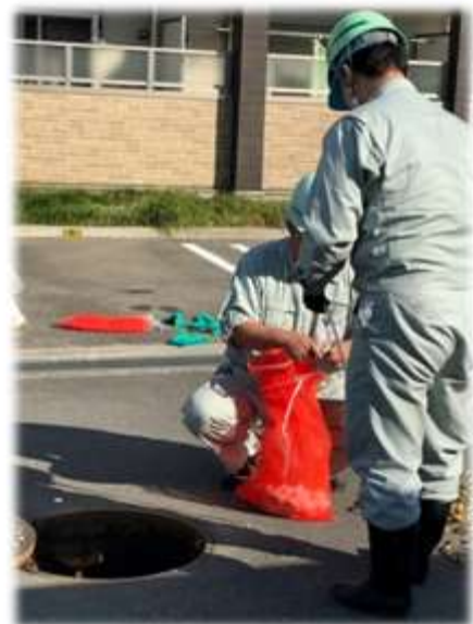
固形塩素による消毒状況
