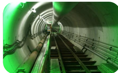
完成したトンネル内の様子
